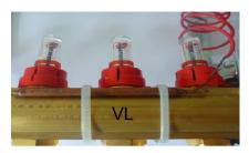
Montieren Sie den Maximalthermostat im Verteilerschrank und befestigen Sie den Fernfühler fest an der Oberfläche, des Vorlauf-Verteilerbalkens (s. Bild)
