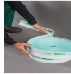
Schutzfolie entfernen und den Streifen mit dem selbstklebenden Fuß über die gesamte Länge auf den Untergrund andrücken. Hierdurch wird ein Durchlaufen der Ausgleichs-/Nivelliermasse zur Wand verhindert und die schalltechnische Entkopplung ist gewährleistet.
