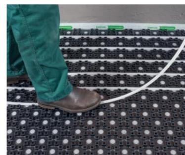
Das PE-RT Kunststoffrohr ist **drallfrei** nach den Auslegungs- und Planungsvorgaben im entsprechenden Heizkreisabstand und unter Einhaltung des erforderlichen Biegeradius zu verlegen. Durch die drallfreie Verlegung ist die dauerhafte Fixierung der Rohre innerhalb der Rohrhaltenoppen gewährleistet.
